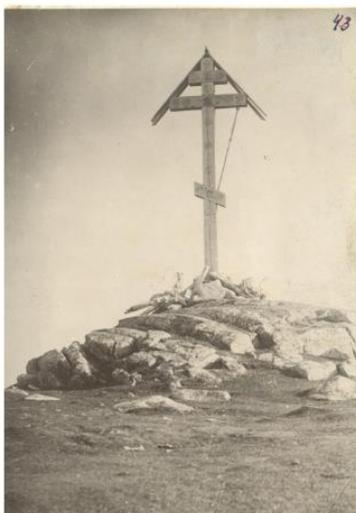
2. Кресты являлись своеобразными навигационными приборами. Они позволяли мореходу, не имевшему магнитного компаса, взять ориентировку и с помощью деревянного компаса-матки определить нужный курс.
